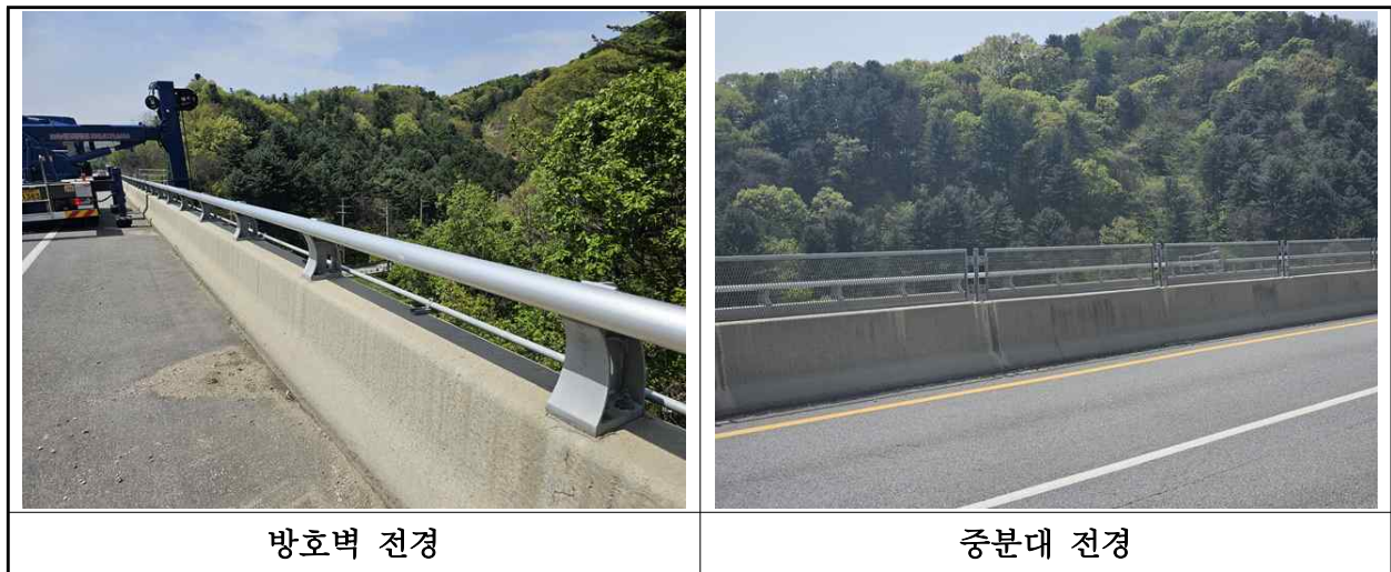
【사진 5.3.23】 방호벽 및 중앙분리대 전경
