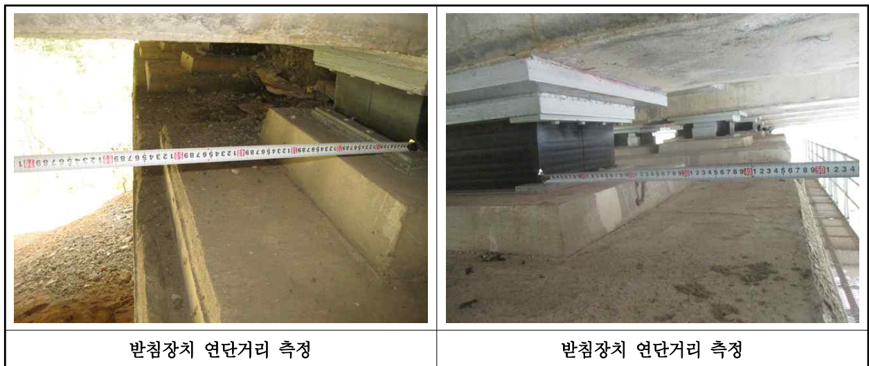
【사진 5.3.14】 교량받침장치 연단거리측정
