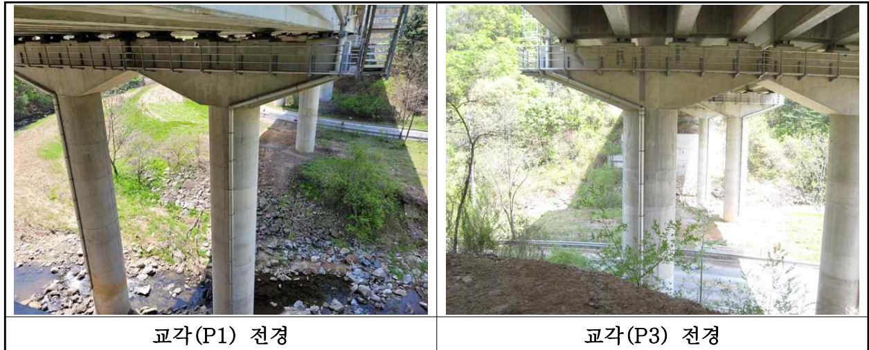
【사진 5.3.10】 교각 전경
