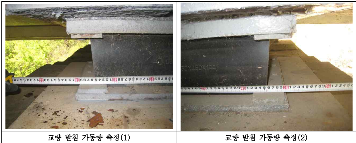
【사진 5.3.15】교량받침 이동량 측정
