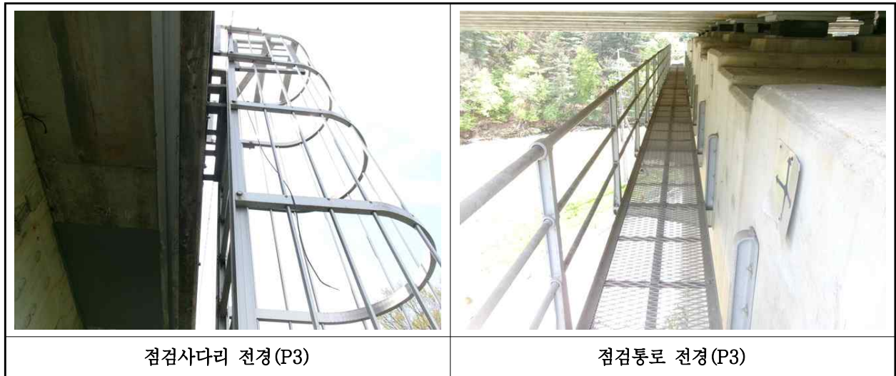
【사진 5.3.25】 교량 점검시설 전경
