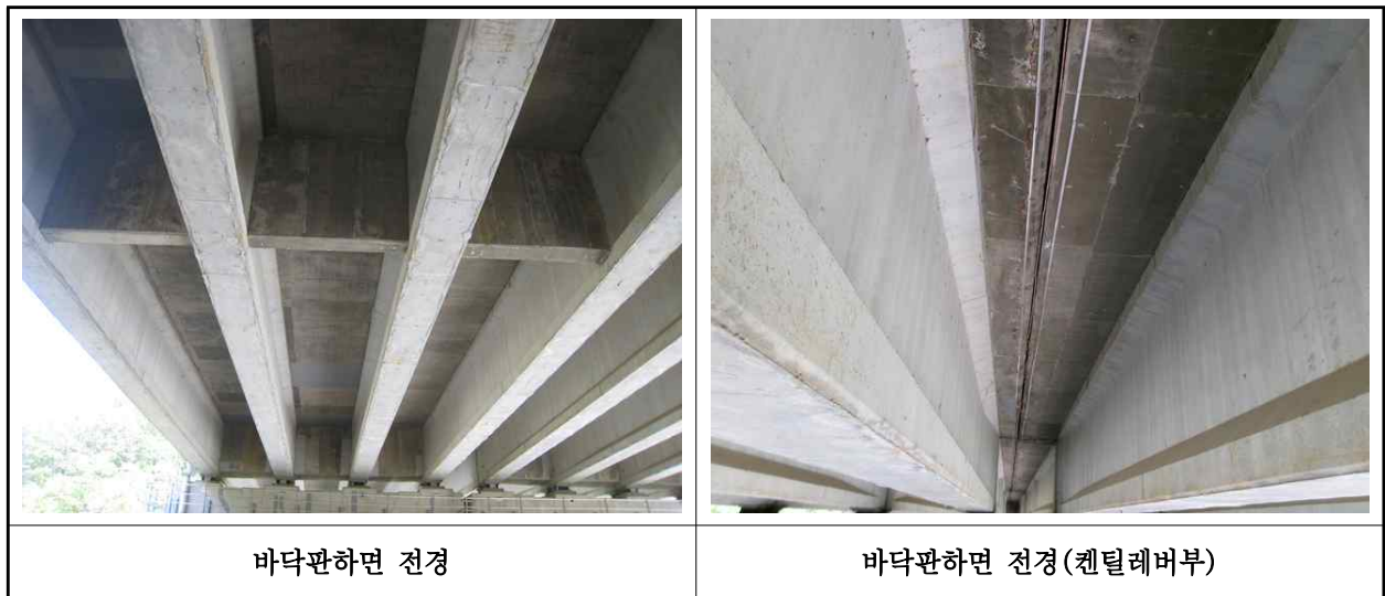
【사진 5.3.2】 바닥판하면 전경
